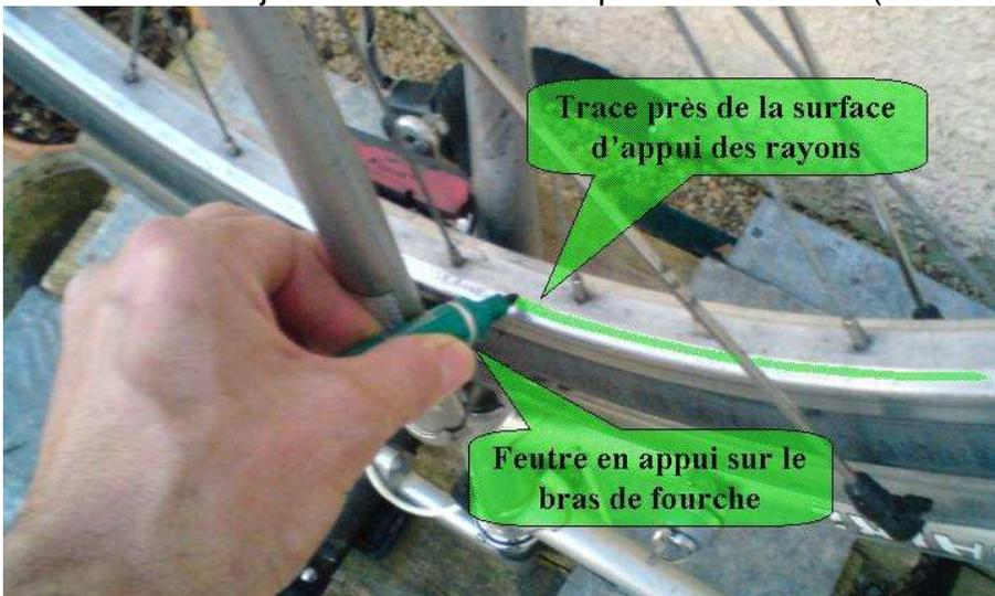
De même que pour le dévoilage, la demi longueur de chaque trace laissée par le feutre correspond au décalage radial le plus important.
